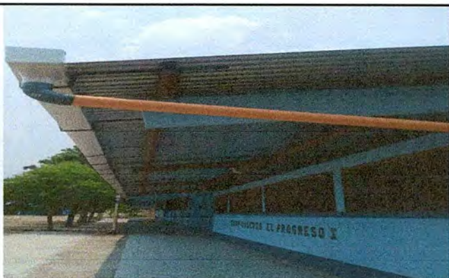
Foto 3: Vista lateral de la instalación de canales en el área de módulos de preprimaria.
