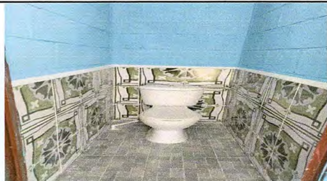
Foto 11: Vista frontal de los módulos de baños de preprimaria.
