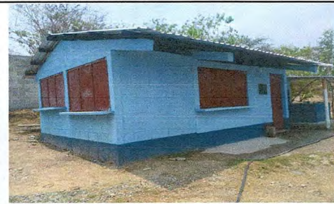
Foto 10: Vista lateral de la cocina con remozado y ampliada en techo y pintura.
