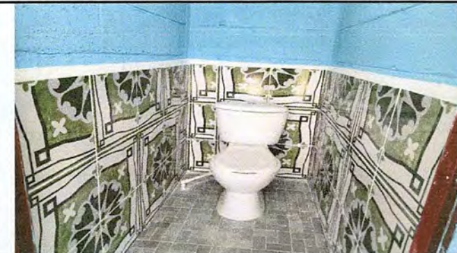
Foto 12: Vista de los módulos de los baños del establecimiento, debidamente remozados.
