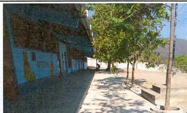
Foto 8: Vista lateral del corredor del establecimiento, debidamente remozado en el entortado.
