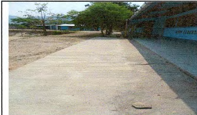
Foto 7: Vista frontal del entortado finalizado, frente a los módulos de preprimaria.
